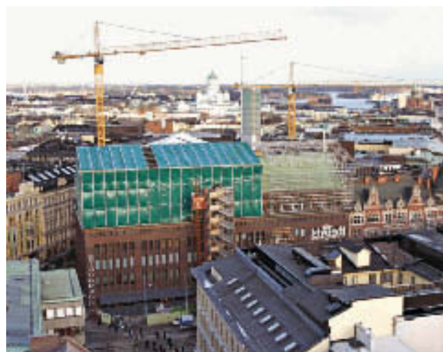
Olägenheterna som byggarbetena medför i Helsingforsvaruhuset har skyddats med noga genomtänkta temporära konstruktioner. Temporära stälpelare bär vackert upp det temporära taket på kosmetikavdelningen.
